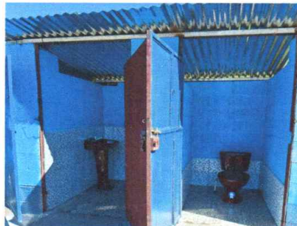
Foto 2: Paredes de baños con azulejo instalado y reforzamiento terminado
