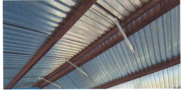
Foto 2: Estructura de soporte de metal instalada
