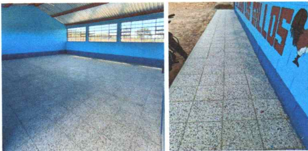
Foto 5: Piso de granito instalado en aulas y corredor
