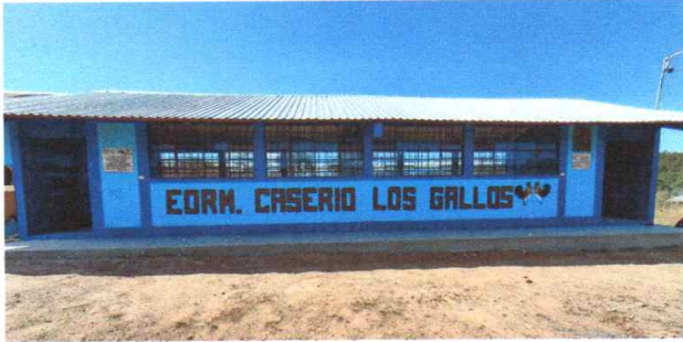
Foto1: Cubierta de lámina instalada
