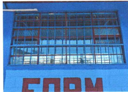
Foto 4: Balcones y vidrios instalados
